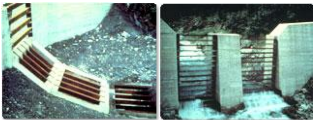
Рисунок 5.17 – Дегидратация селевого потока. (Soil and Water Conservation Bureau, SWCB)
