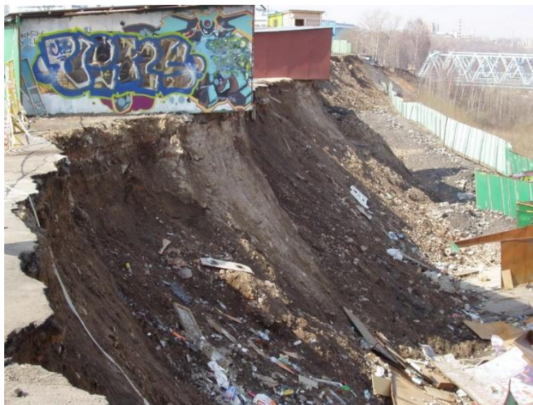
Рисунок 6.26 – Активизация оползневого процесса в районе Москворечье в сентябре 2009 г. (Фото ФГУП «Геоцентр-Москва»)
