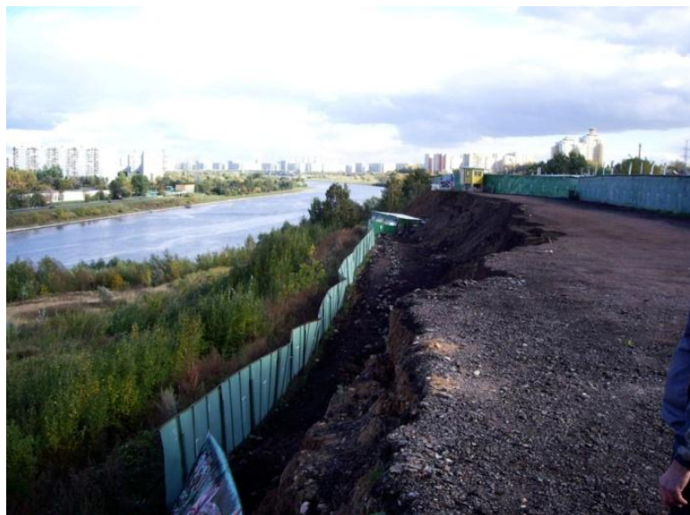
Рисунок 6.25 – Активизация оползневого процесса в Хорошево (Фото Казеева А.И.)
