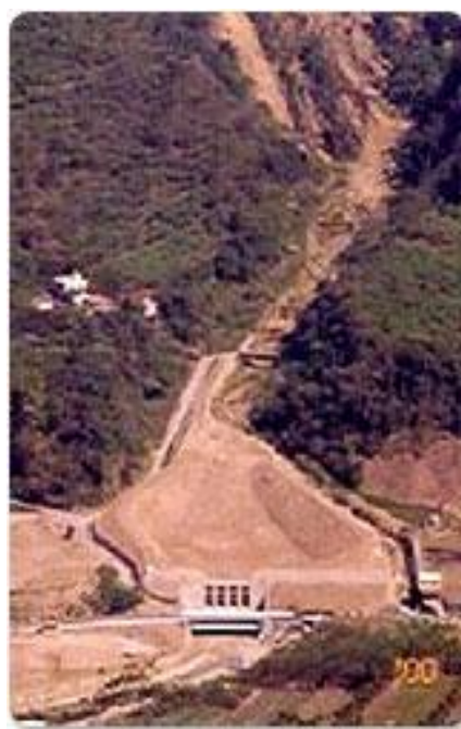
Рисунок 5.19 – Организация зоны осаждения селевого потока. (Soil and Water Conservation Bureau, SWCB)
